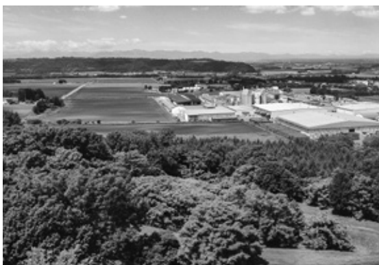
「明野ヶ丘公園からの眺望（ドローンによる撮影）」
