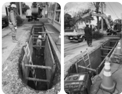
みずほ通配水管布設工事（令和3年）
