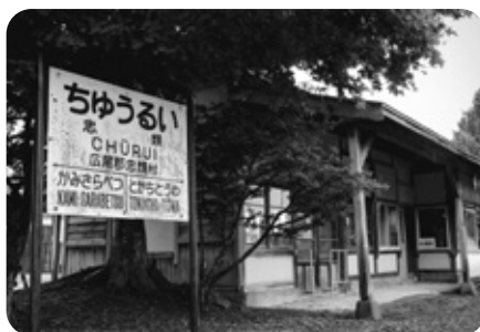
交通公園（旧忠類駅舎）外観
