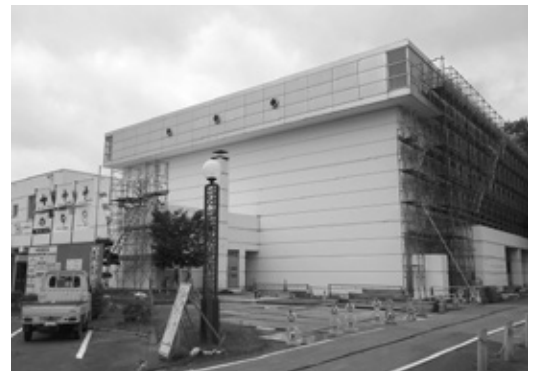
改修工事がはじまった 農業者トレーニングセンター
