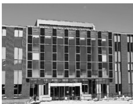
役場庁舎南側壁面の 太陽光パネル
