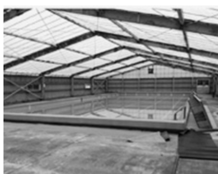
老朽化が著しい札内東町民プール
