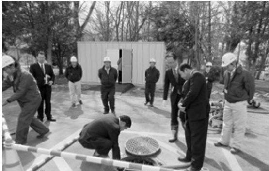
耐震性貯水槽の現地視察 （幕別小学校駐車場）
