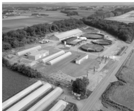
鹿追町バイオガスプラント (写真は鹿追町提供)
