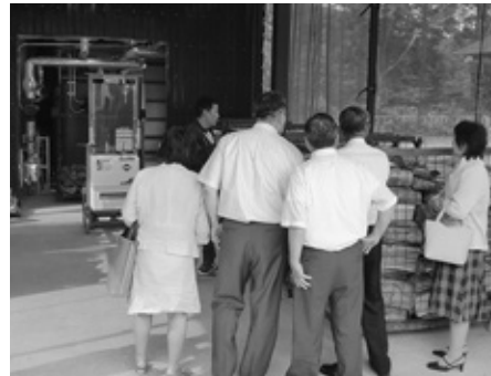
低コストの薪ボイラーを視察（約3600万円の事業費）。
