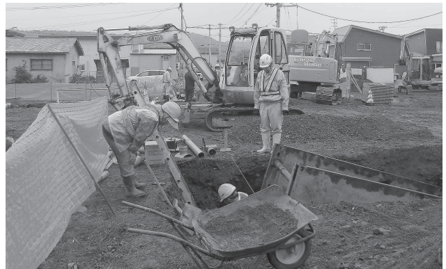
緊急経済対策として行っている生活道路工事
