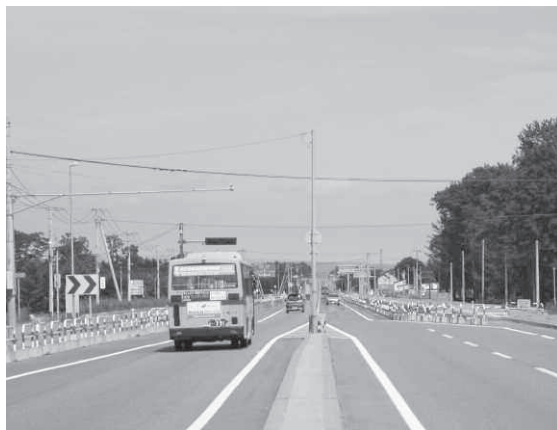
国道38号線4車線化工事
