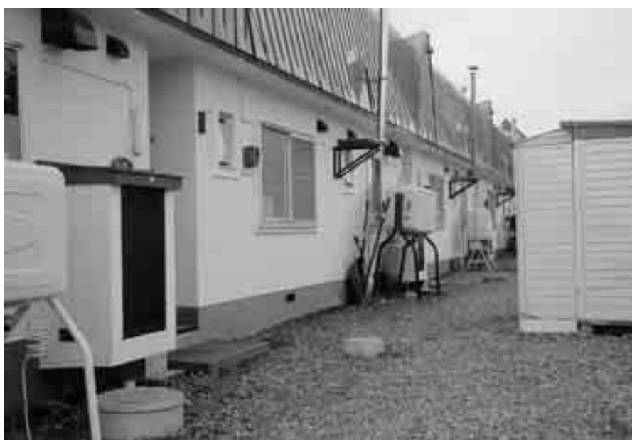
未舗装の公営住宅玄関前
