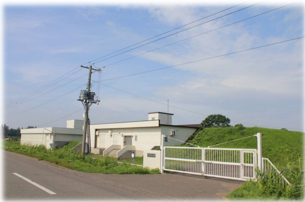
札幌配水池（全景）
