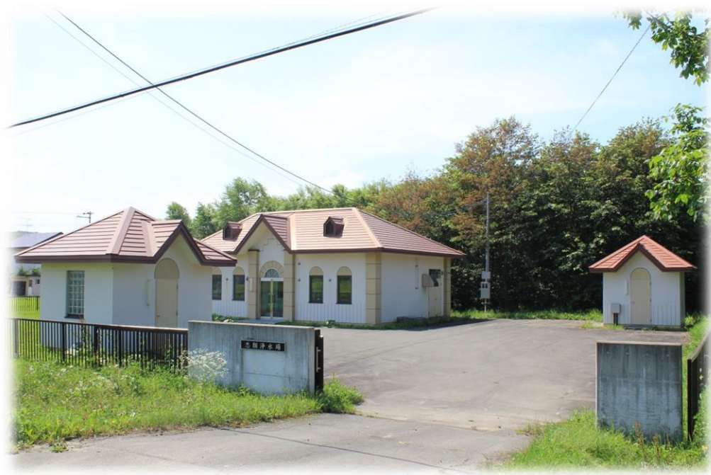
忠類浄水場（全景）
