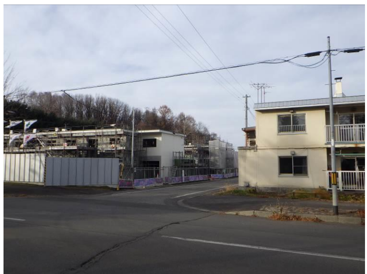
公営住宅新築工事（桂町西団地）
