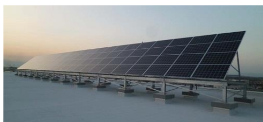
公共施設への太陽光パネルの設置
