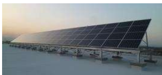
公共施設への太陽光パネルの設置
