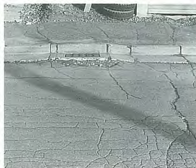
凍結などより段差ができている
