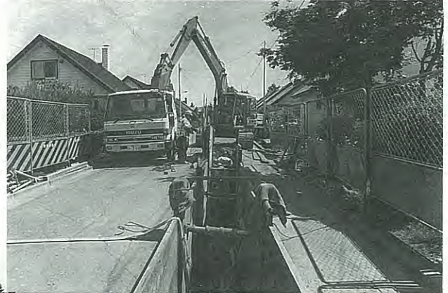
下水道工事も急ピッチ（札内桂町地区）
