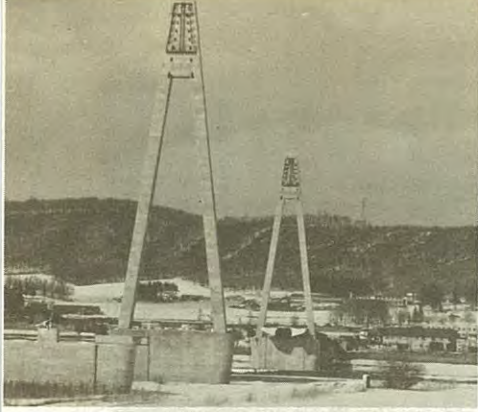
架橋工事が進む十勝中央大橋
