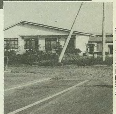
市街化区域内の秩序ある発展を図り、都市施設の整備を促進 (写真=札幌北區画整理)
