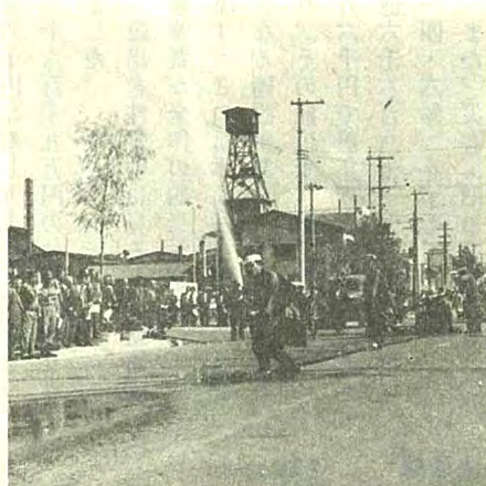
▲大正時代のポンプで放水
