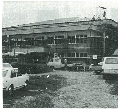
完成直近の札内中体育館
