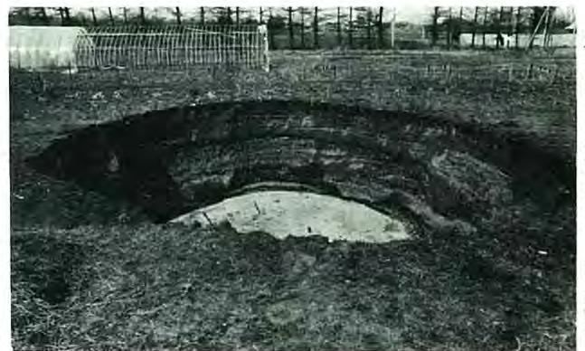
流水が何らかの原因により流れが停止され、芥さんの畑に滞留し、この地の水量の増大とともに加圧が起り、次に水が排出される。この排水するときに吸引圧が生じて砂礫が持ち去られる。これが繰り返されて内部が空洞化され、次に先日の雨で表層がゆるみ、急激に畑の落下、沈没が起つたものと推定される。(5月6日現在、田村教授談の原因推定)
