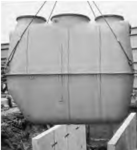
合併浄化槽設置の様子
