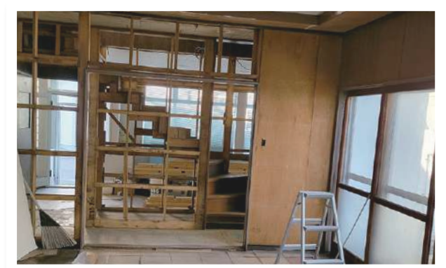
改修中の様子
