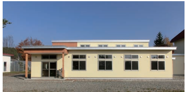
▲増築された札内南小学校
