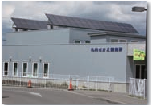
▲太陽光発電システムを採用したさかえ保育所
