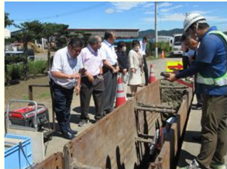
R5. 8. 18 所管事務調査（建設部） 下水道処理区統合連絡管渠整備工事について （工事現場（字明野）を視察）
