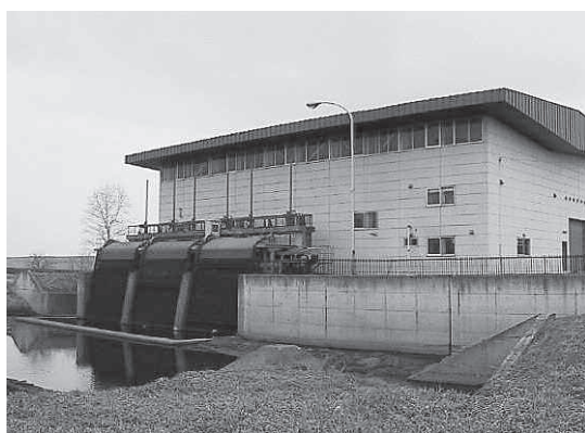
上統内排水機場
