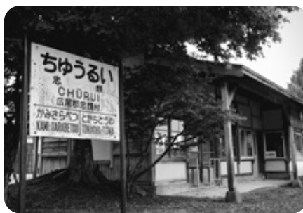
交通公園（旧忠類駅舎）外観
