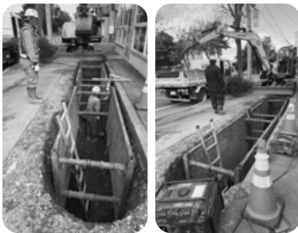
みずほ通配水管布設工事（令和3年）
