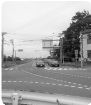
国道38号止若橋
