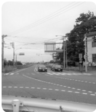
国道38号止若橋
