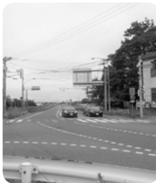
国道38号止若橋
