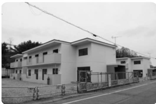
公営住宅等長寿命化計画に基づき整備が進む桂町西団地
