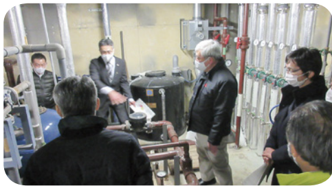
アルコ 236 ろ過室
