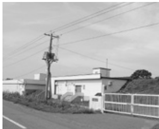
札内配水池（日新）耐震補強を実施予定
