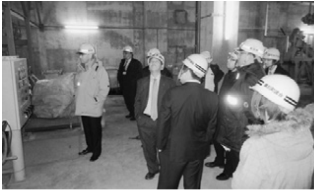
札内中継ポンプ場の現地視察
