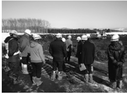
河道掘削工事の現地視察
