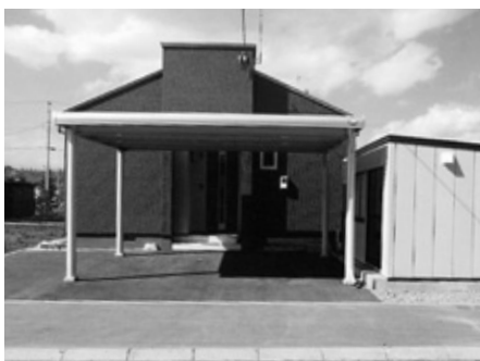
定住促進住宅建設費補助金を活用し、新築された住宅
