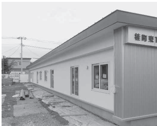
改修工事中の札内桂町東団地
