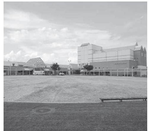
指定管理者制度を導入し 委託している百年記念ホール
