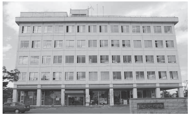
庁舎建設に関する特別委員会で協議している役場庁舎
