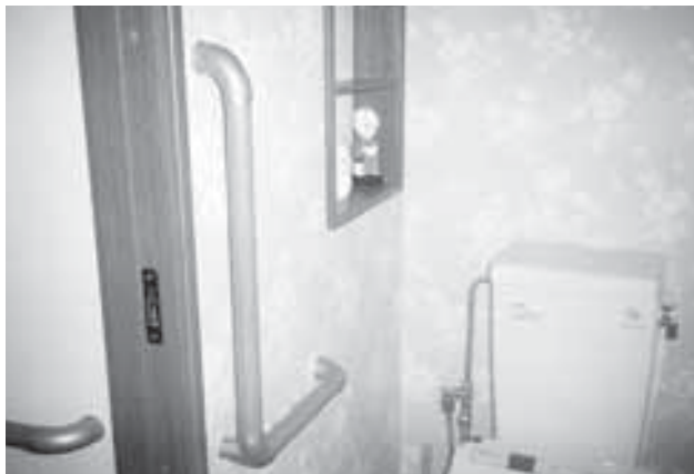
リフォームにより手すりをつけたトイレ
