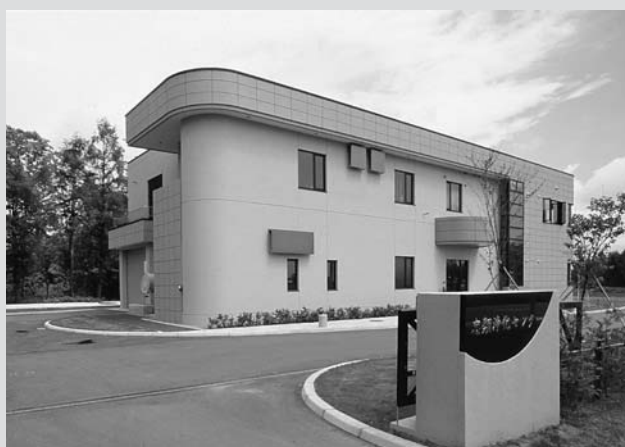
忠類浄化センター
