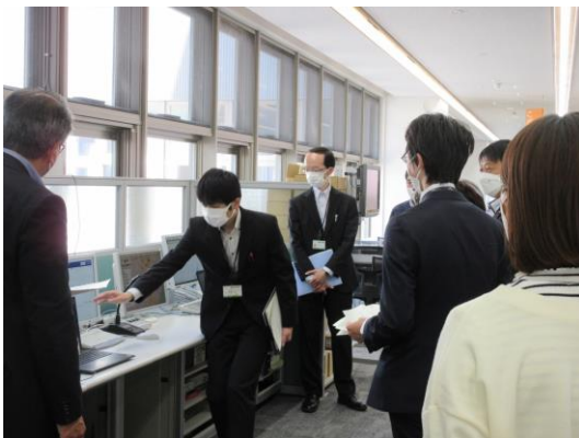
防災行政無線札内基地局（本庁舎1階）
