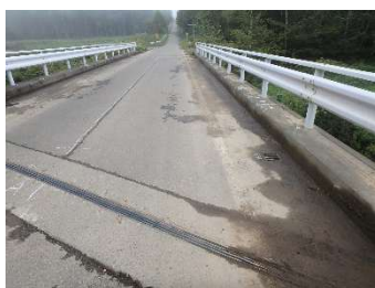
清掃後（橋面土砂堆積）
