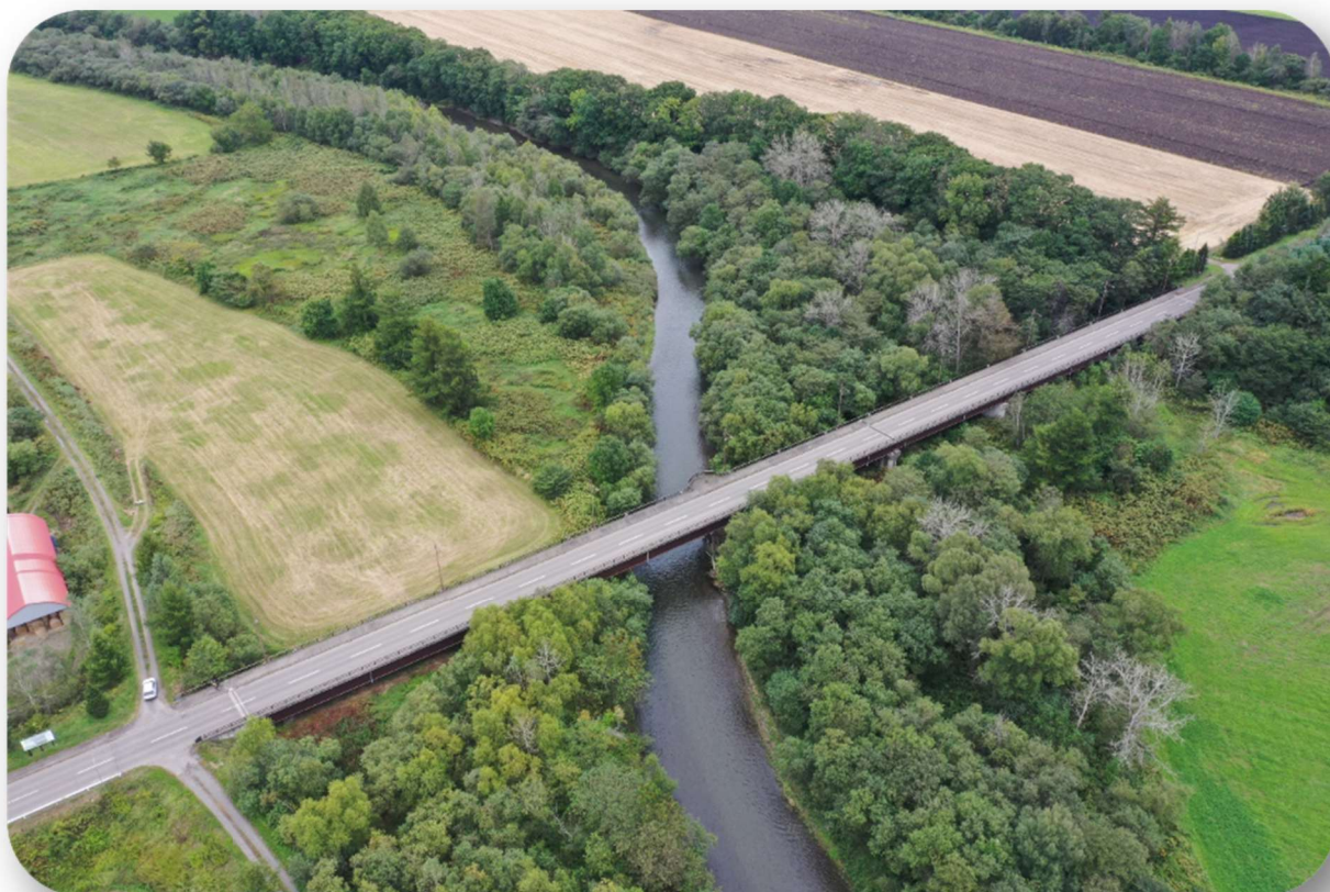
猿別大橋 橋長 242.5m 竣工年 1998年
