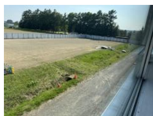
2Fから見たグラウンド側増築場所
