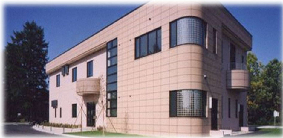
忠類浄化センター（全景）
