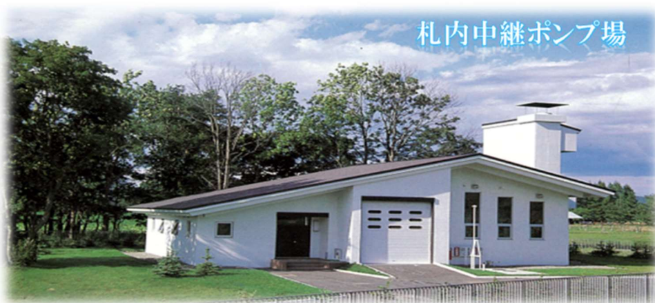
札内中継ポンプ場（全景）
