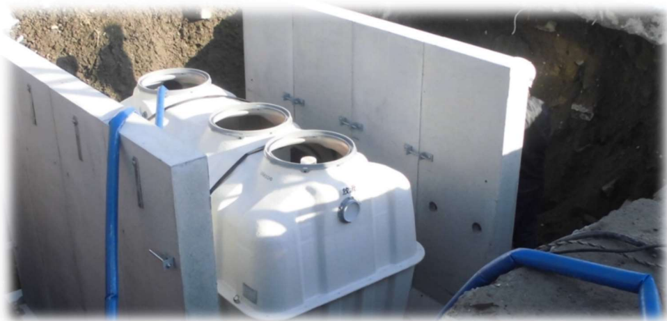
合併処理浄化槽設置工事の様子
